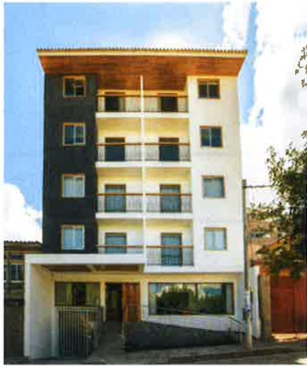
Fotografía 2: Fachada del hotel Muru Homely (Fuente: Elaboración Propia)
